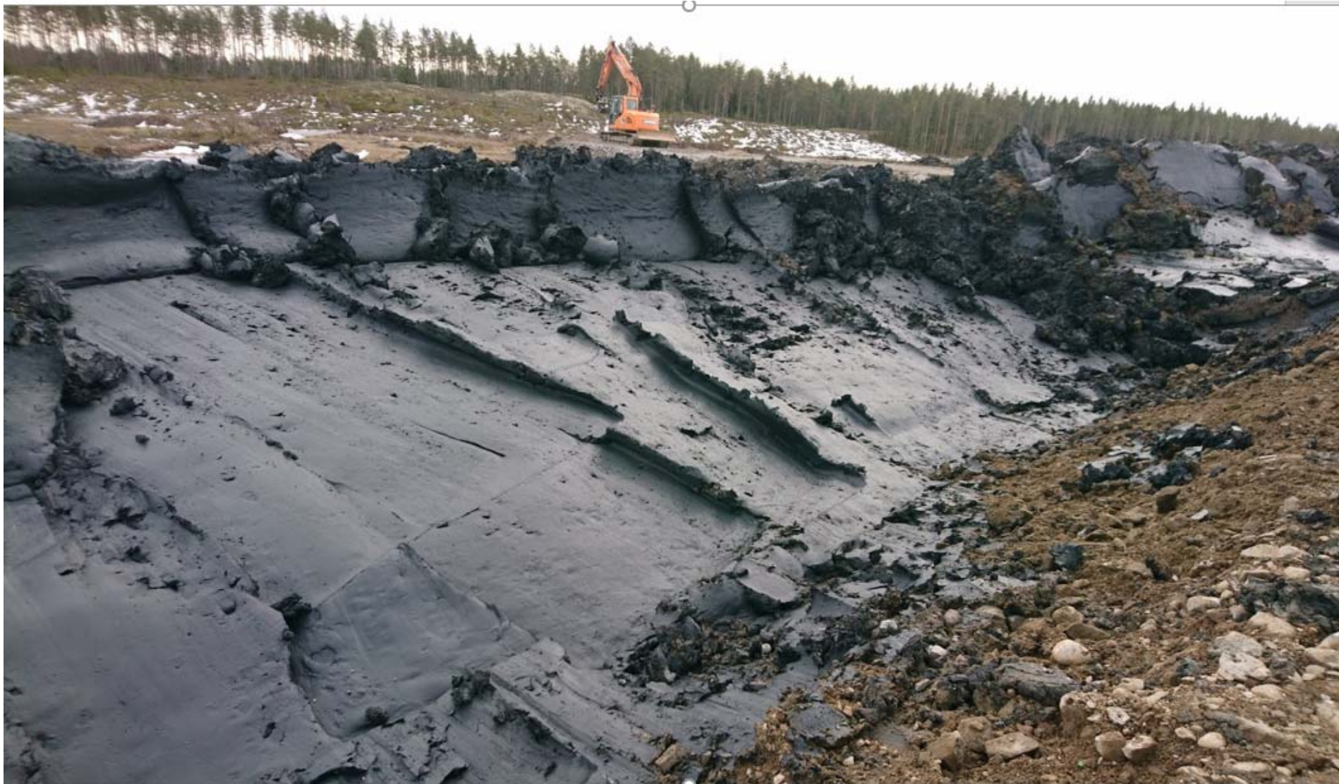
Sulfidisaven läjittäminen
